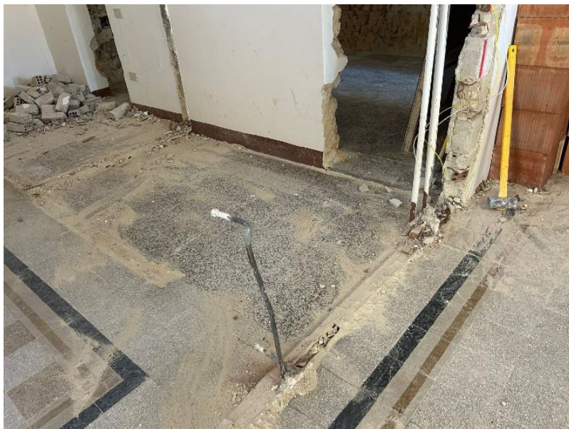
diversa quota del pavimento a seguito della demolizione
