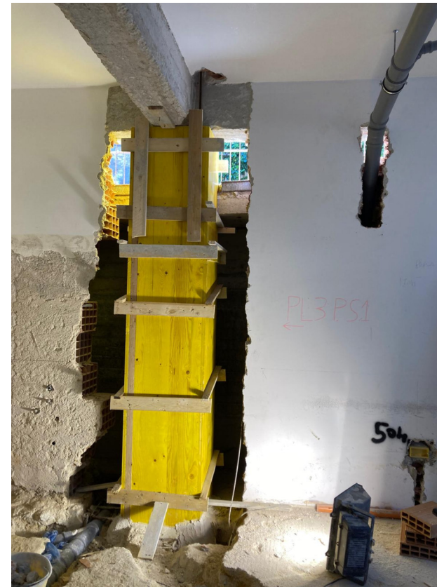
PILASTRO 3 PIANO S1 ( intervento a camicia)
