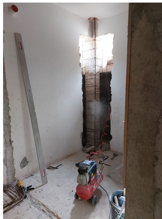
PILASTRO 2 PIANO S1 ( intervento a camicia)
