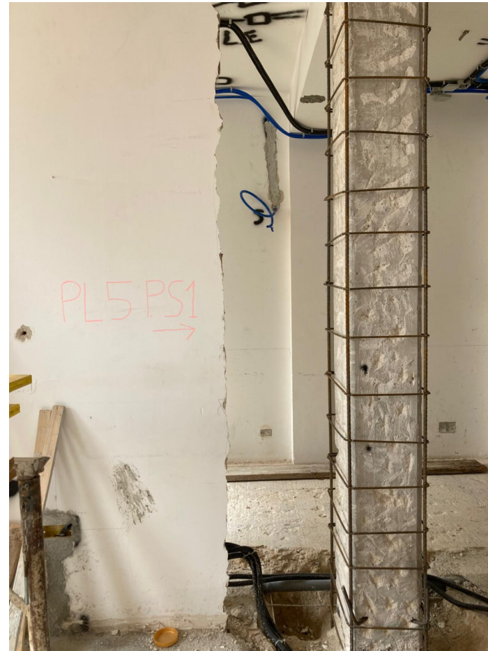
PILASTRO 5 PIANO S1 (intervento a camicia)
