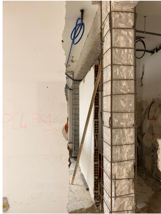
PILASTRO 4 PIANO S1 ( intervento a camicia)
