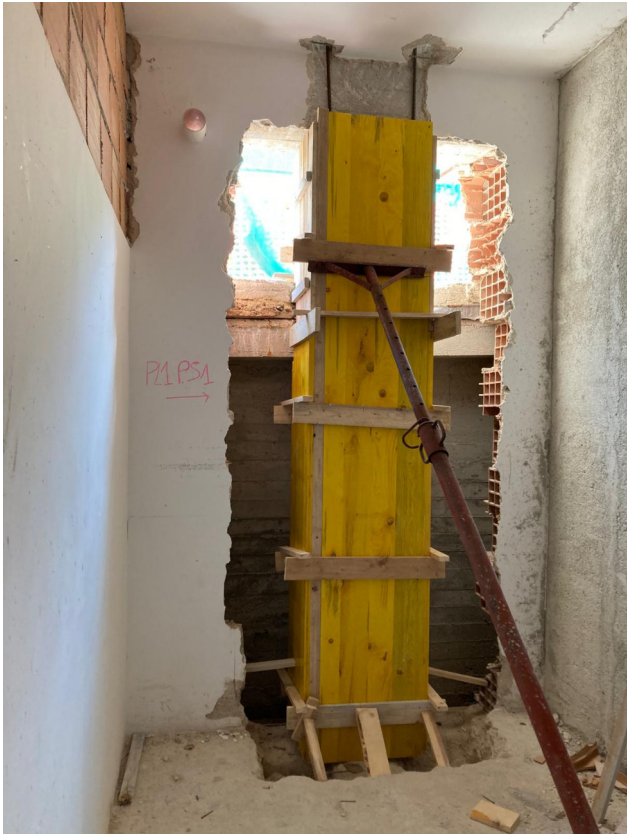
PILASTRO 1 PIANO S1 ( intervento a camicia)
