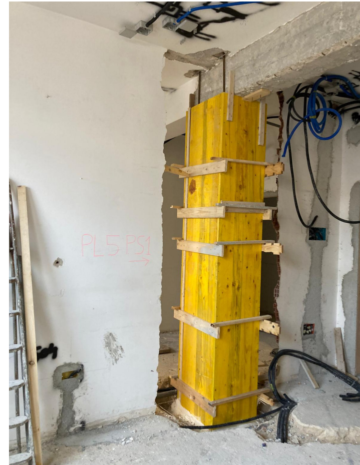
PILASTRO 5 PIANO S1 (intervento a camicia)
