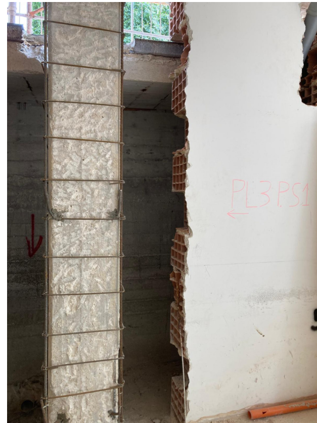
PILASTRO 3 PIANO S1 ( intervento a camicia)
