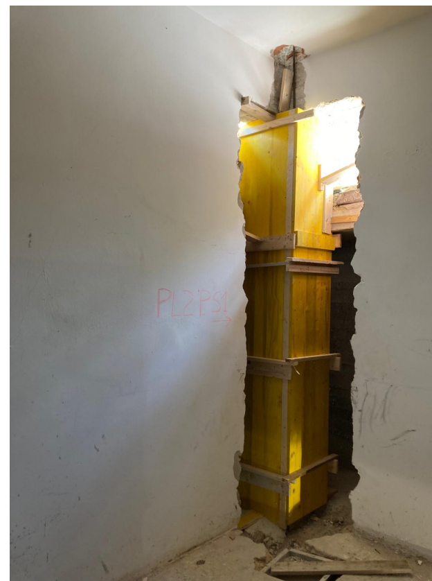
PILASTRO 2 PIANO S1 ( intervento a camicia)
