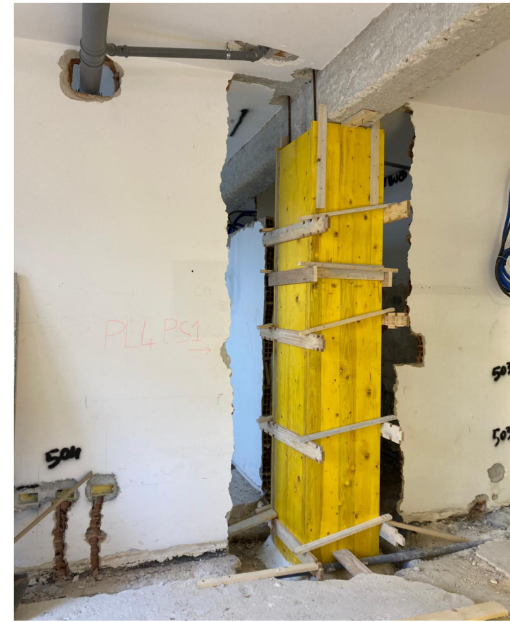
PILASTRO 4 PIANO S1 ( intervento a camicia)
